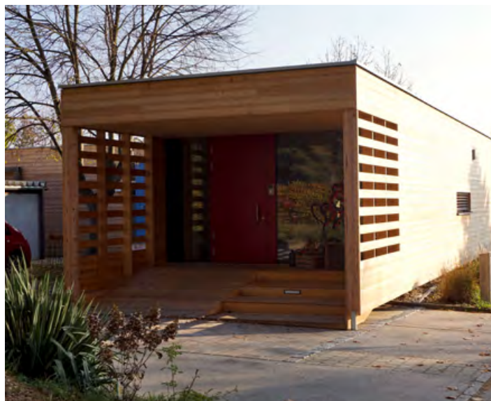
Das Gebäude wurde in Holzbauweise errichtet.
