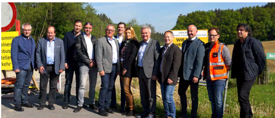
Baustellenbesichtigung an der L404 mit Verkehrslandesrat Anton Lang.
