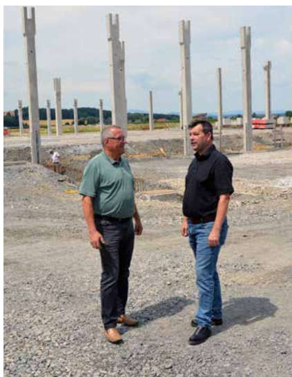
Bgm. Rupert Fleischhacker mit Ing. Martin Luisser auf der Baustelle.
