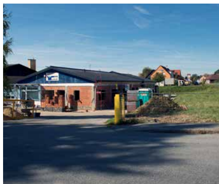
Aktuell steht die moderne Zahnarztpraxis noch in Bau.
